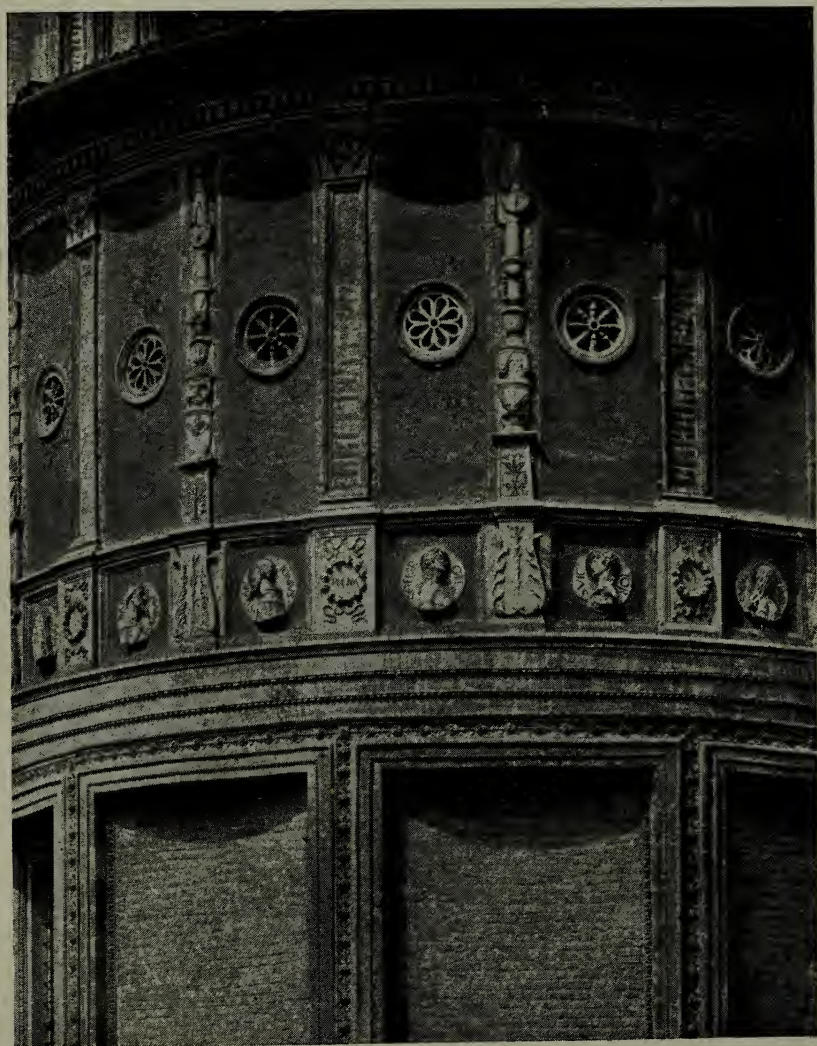
ABSIDE DI SANTA MARIA DELLE GRAZIE (particolare)
